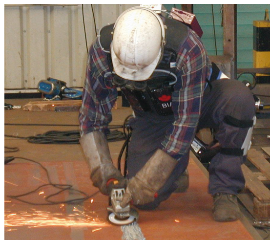
Bild 13 Übliches Verfahren mit Winkelschleifer bei der Vorbereitung von Schweißnähten.
