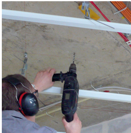
Bild 1 Verwendung von Schlagbohrmaschine oder Bohrhammer zum Setzen von Befestigungsdübeln.
